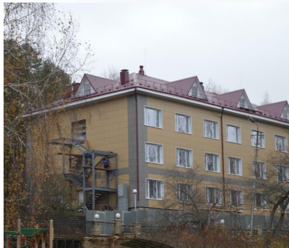
Строительство лечебного корпуса санатория Варзи-Ятчи на 80 мест
